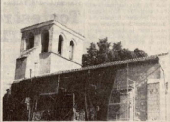
Une vue des travaux sur les murs extérieurs (Photo Sud-Ouest)
